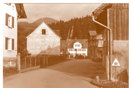
Durch den Bau der Unterführung Churer Straße verschwand der Bahnübergang und Wohnhäuser mussten dem zweigleisigen Ausbau der Bahnstrecke weichen.
