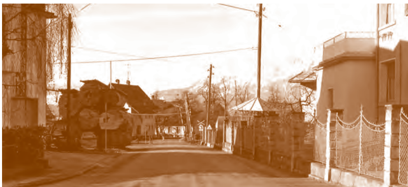
Die Aufnahme von der Landamannasse vor dem Bau der Unterführung zeigt den erforderlichen Eingriff in das Ortsbild besonders deutlich.
